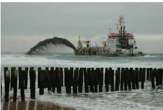
Afbeelding 8. Zandsuppletie. (Rijkswaterstaat, Adviesdienst Geo-informatie en ICT, Beeldbank Ministerie van Verkeer en Waterstaat)
