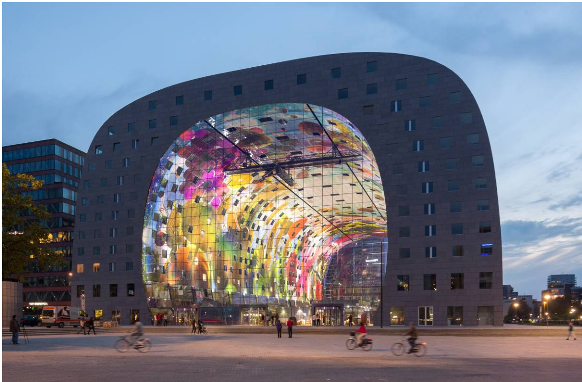
Foto kabelnetgevels Markthal, Rotterdam
